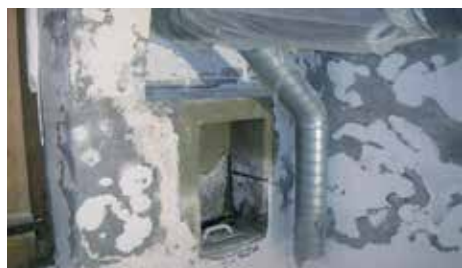
1 A felújítás előtti állapot
