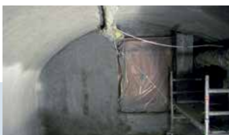
5 A második réteg; felújító vakolat
