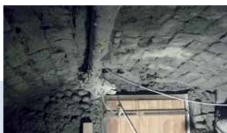
4 Az első réteg; VANDEX UNI MORTAR 1
