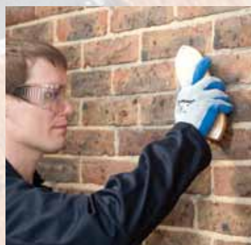
Felület előkészítése
